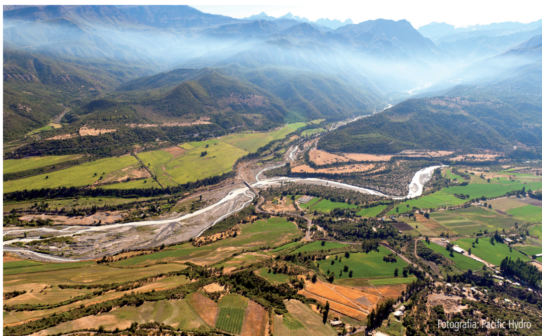
Figura 1.19. Vista general del sector de Chacayes, en la confluencia de los ríos Pangal y Cachapoal.
