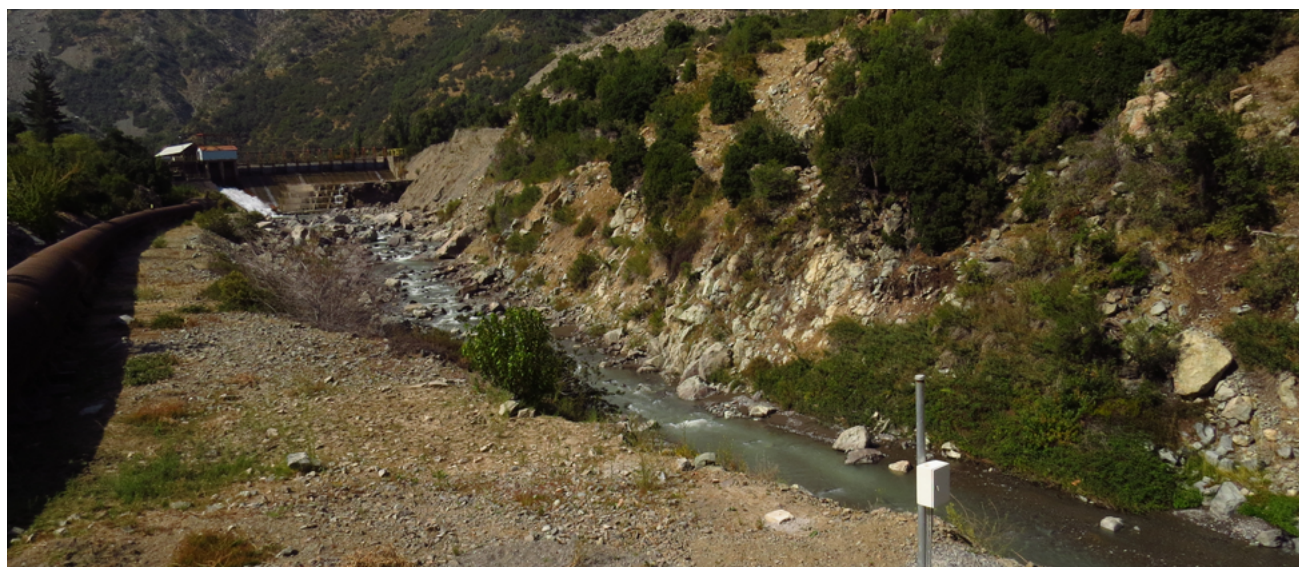
Bocatoma y acueducto de la central hidroeléctrica de pasada Pangal, puesta en marcha en 1921 en la cuenca del río Pangal, importante afluente del río Cachapoal.
