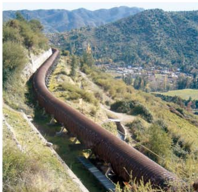
Por este acueducto de madera, una joya de la ingeniería, construida a principios del siglo XX, se lleva parte de las aguas del río Pangal hasta la Central Hidroeléctrica Pangal.
